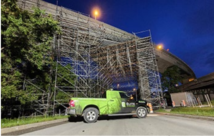
Échangeur St-Pierre, échafaudage en rosette
