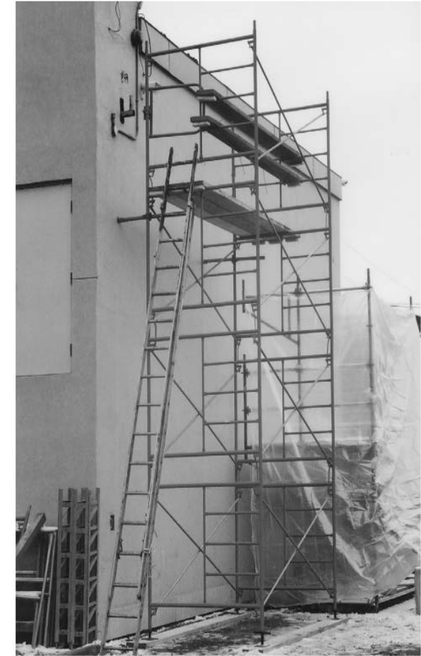
Échafaudage sur cadres métalliques traditionnels
