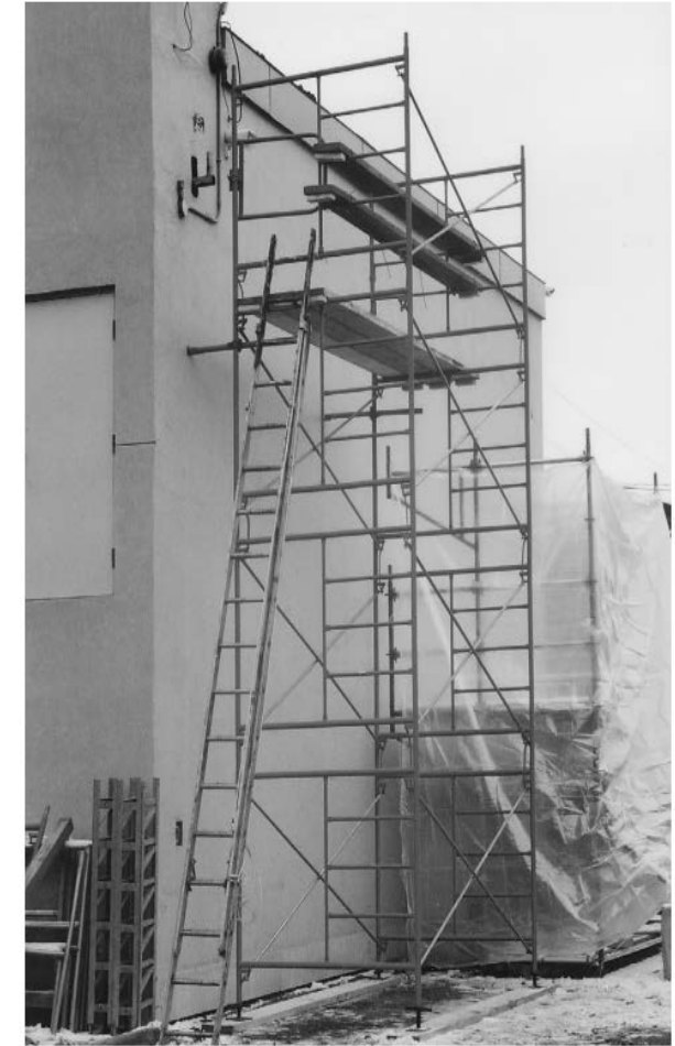
Échafaudage sur cadres métalliques traditionnels
